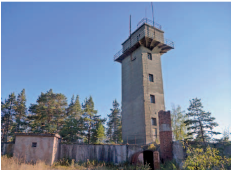
Rikaman jyhkeä tulenjohtotorni Rysäkarilla näkyy Länsiulapanniemelle saakka.
