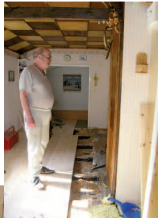
Majassa 241 uusittiin lattia eristeineen...
