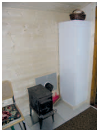
.. ja seinään asennettiin hormin läpivienti. Samalla sisätilat saivat raikkaat paneelit ja nurkkaan mahtui uusi kaappi.
