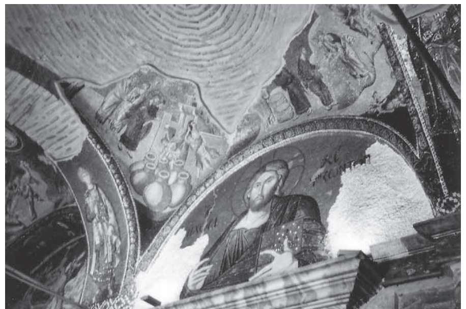
Freskot ja mosaiikkityöt odottavat entisöintiä.
