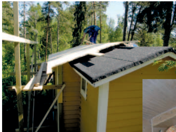
... ja tässä rakentuu uusi katto majaan 244.
