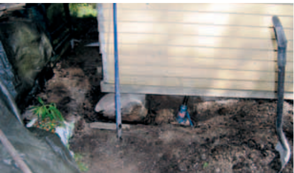
Toukokuussa 2008 oikaistiin ja kunnostettiin majan 254 takaosa...
