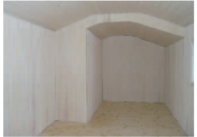
227:n sisätilat ovat lähes valmiit.
