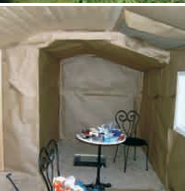
Sisätiloissa eristys ja paneelointi meneillään (227).
