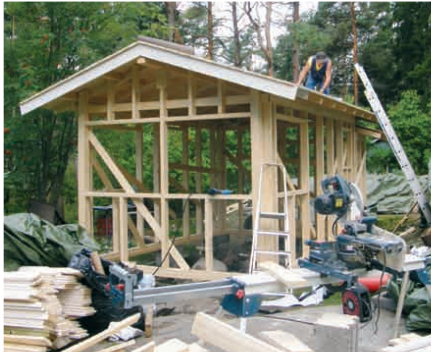
... ja uusi nousee vesikattoon.
