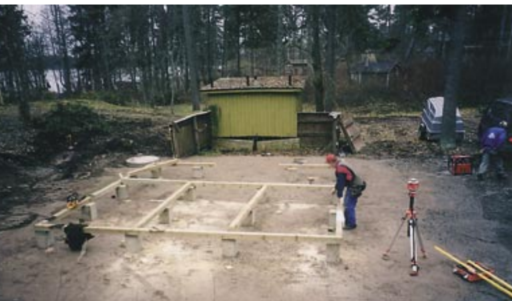
Puuosan rakennustyöt alkoivat 11.11.03.
