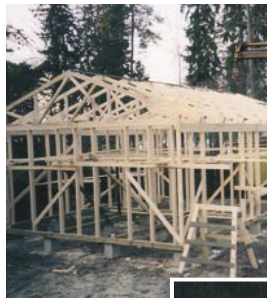
13.11.03 rakennus oli jo niin pitkällä, että kattotuoleja asennettiin paikoilleen nosturin avulla.
