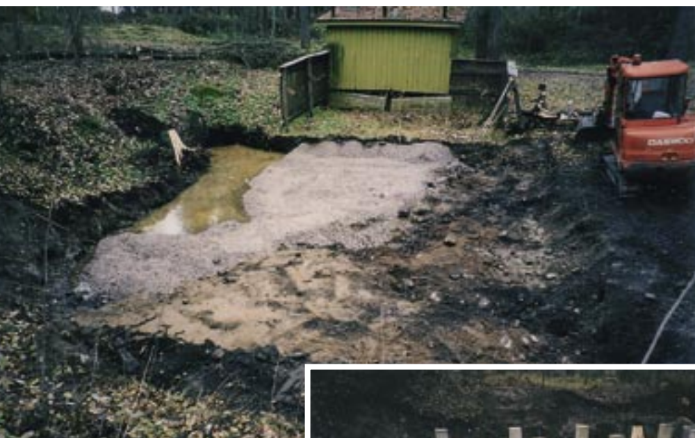
1.11.03 salaojasoraa ajettiin rakennukselle ja rakennuksen alkukorkeus kasvoi.
