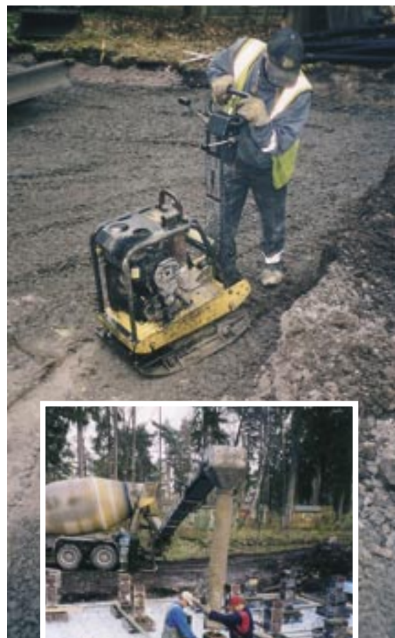
Jone Tauri tasoitti soran tiiviiksi ennen routaeristyslevyjen asentamista.
