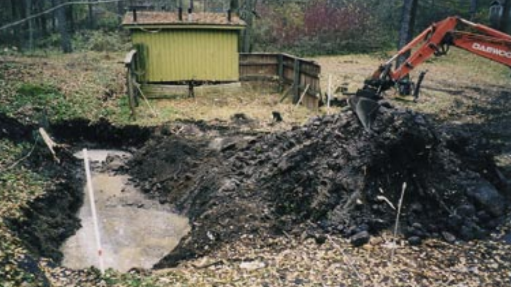
Rakennuspaikka on alava, mutta pohjalla olevan veden korkeus kaikkialla rakennettavalla alueella yllätti. Ei ole ihme, että vanha rakennus lahosi myös alhaalta päin.
