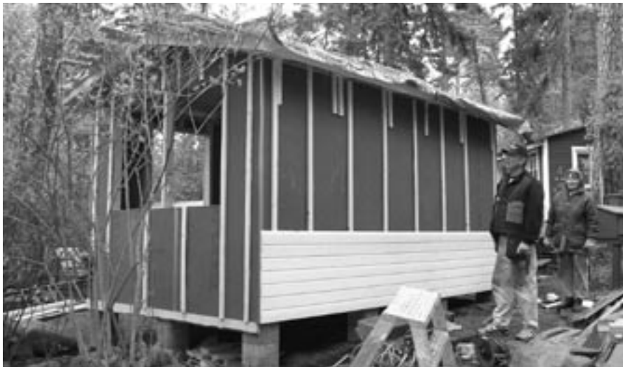
Uuden mökin tuulensuojalevyt ovat jo paikoillaan.
