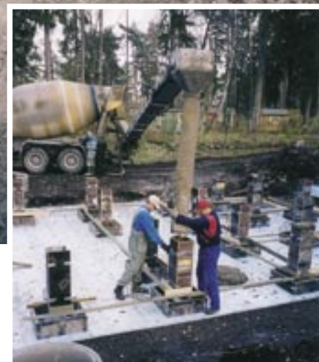
7.11.03 Hartikainen ja Raimo Saarikoski laskivat sementin routaeristyslevyjen päälle laitettuihin peruspilarimuotteihin.
