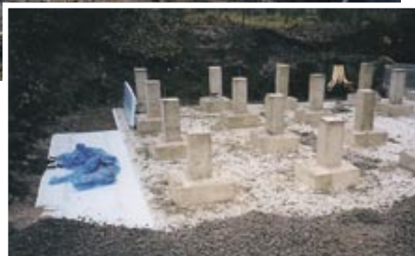
Valun jälkeen rakennusalue täytettiin 10.11.03 vielä soralla.
