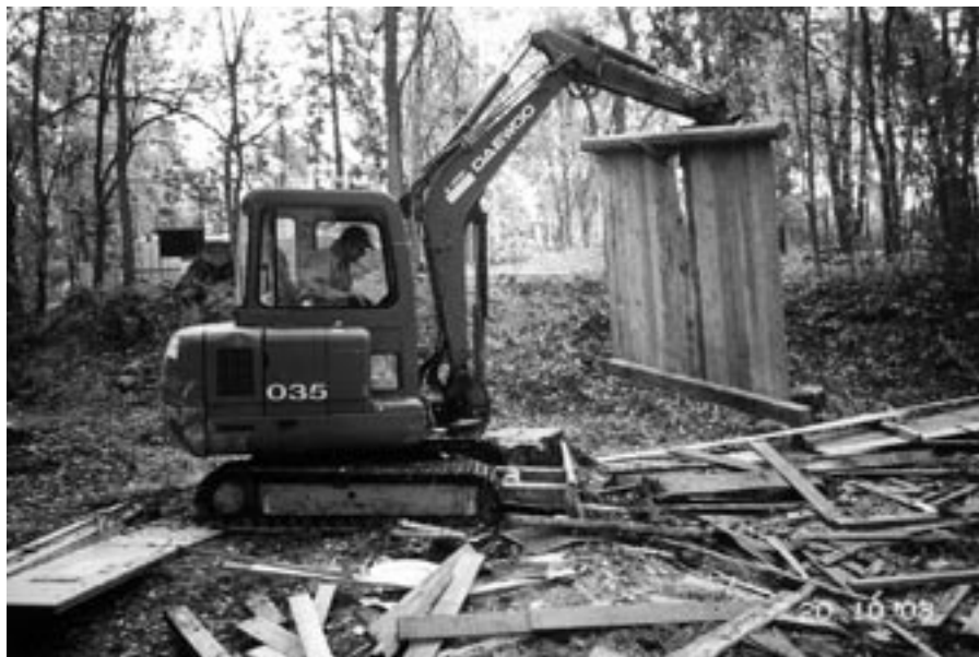
Vanhan varasto/puukäymälärakennus 204 purku ja poiskuljetus vei muutaman tunnin.
