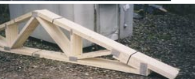
Kattotuolit saapuivat valmiina 11.11.03.
