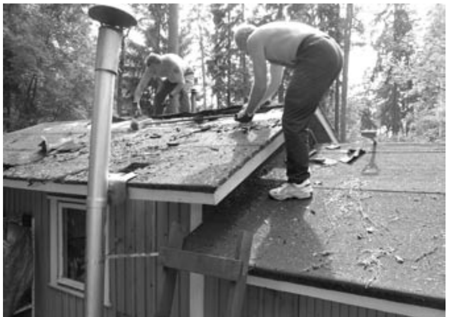
Kattolaudat rutisivat miesten alla ja joutuivat vaihtoon. Aurinko paistoi ja lämpöä riitti työurakassa. Uutukaisen savupiipun päällä on vielä vanha suojahattu, uusi hattu oli tilauksessa.
